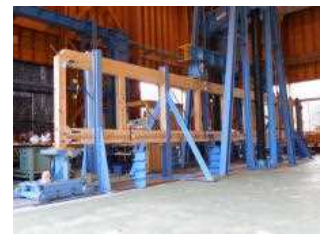
10.8mの平行弦トラスの曲げ試験
