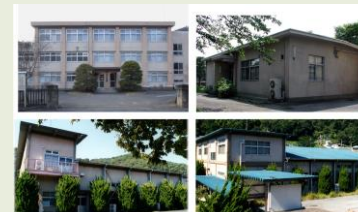
繊維技術支援センター（現有建物）
